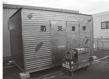
防災備蓄倉庫とレスキューキッチン
